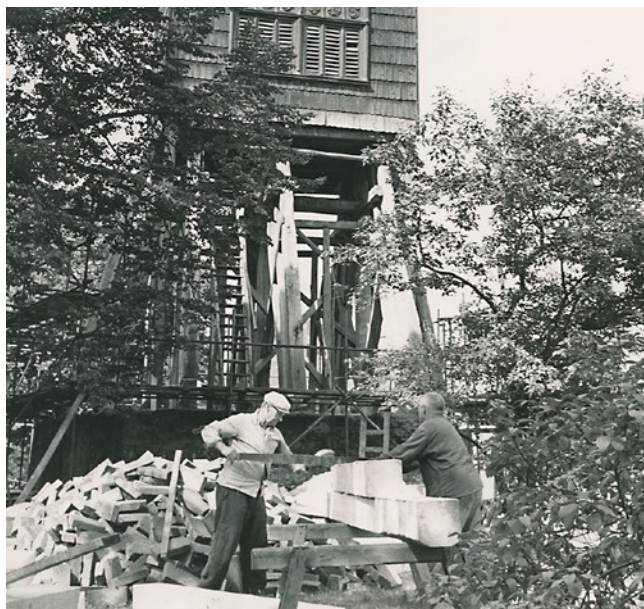
Oprava zvonice u kostela sv. Bartoloměje
