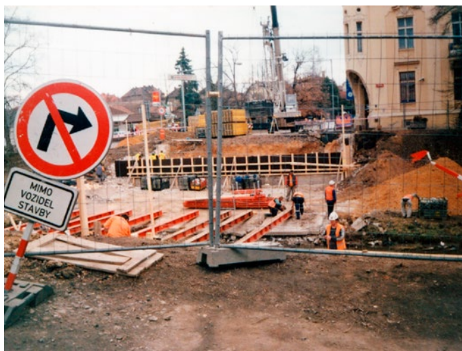
Stavba mostu přes Rakovnický potok. Foto Štýbrová, 2014
