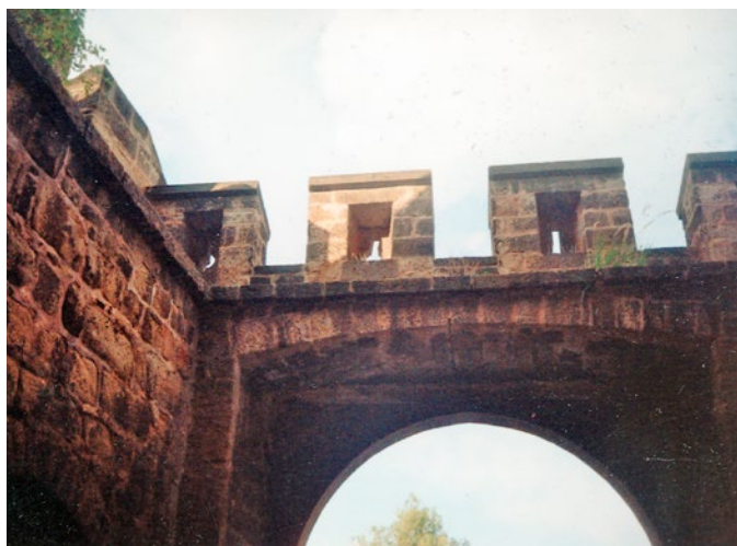
1. Poznáte, kde stojí tento objekt? Foto Hvězda
