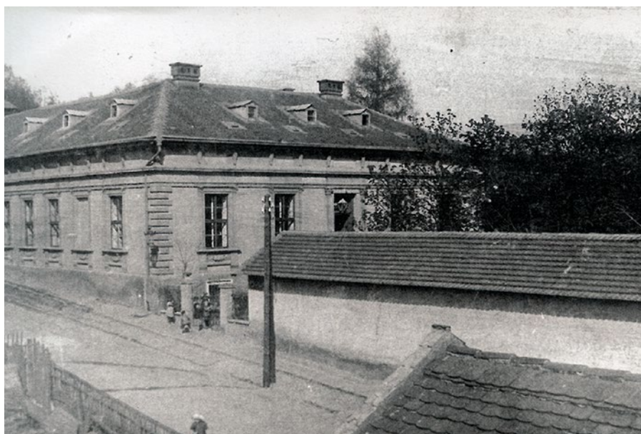
2. V které ulici stávaly tyto budovy? Neznámý autor, 30. léta
