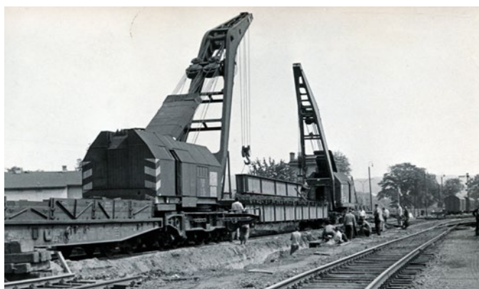
Výměna železničního mostu u Vrchlického náměstí, foto Uher, 2000
