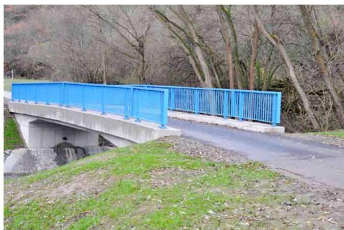
Most č. 17 přes Rakovnický potok pod Papírnou
