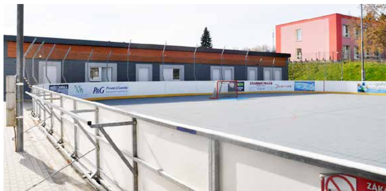
Nové šatny na hokejbalovém hřišti
