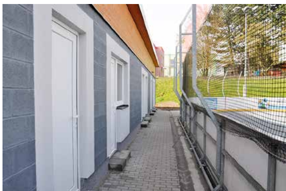
Nové šatny na hokejbalovém hřišti
