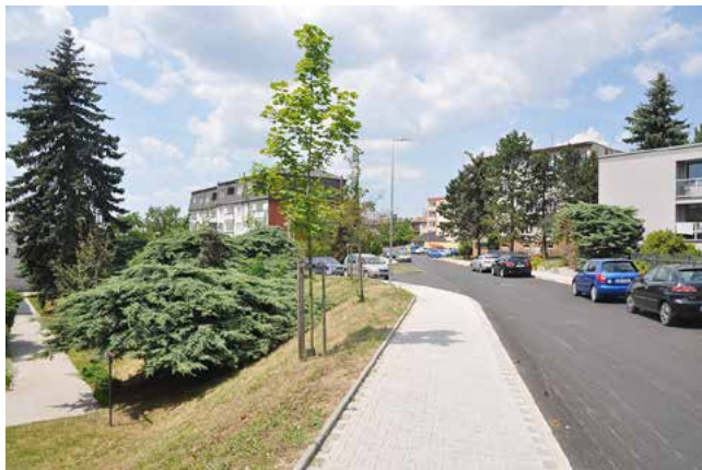
Rekonstrukce ulice Pod Václavem
