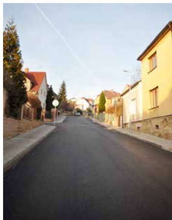
Rekonstrukce ulice Bratří Burianů
