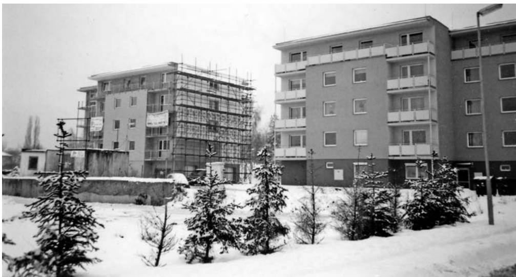
2. Kdepak se to staví? Foto Hvězda, 2010
