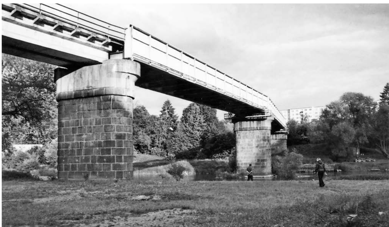
4. Kde stojí tento most přes Starou řeku? Foto V. Hvězda, 2012
