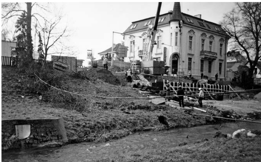
Budování nového mostu přes Rakovnícký potok v Nádražní ulici. Foto Štýbrová, 2011 – 12
