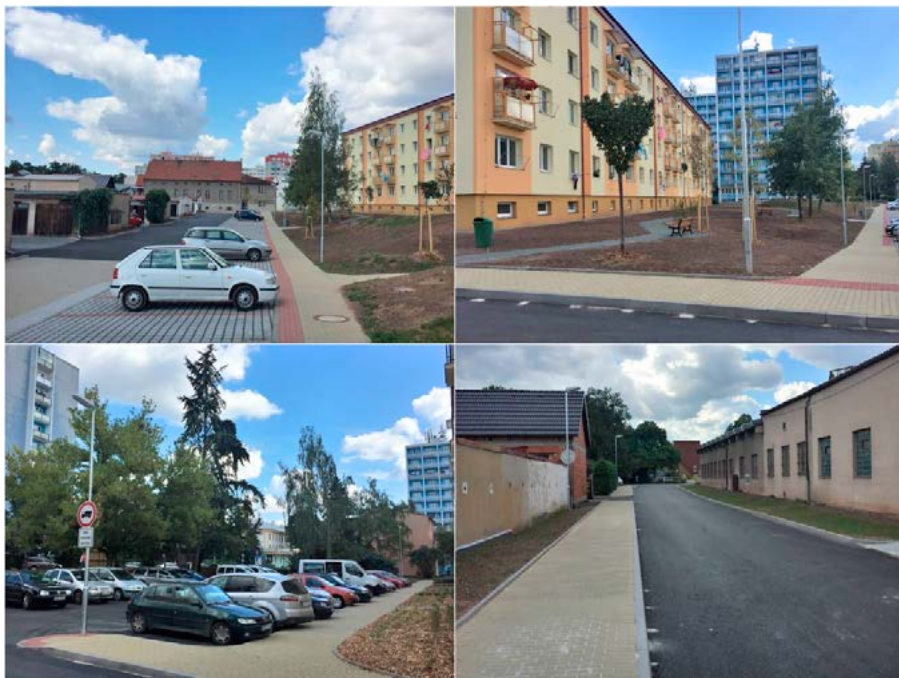
Rekonstrukce Sportovní ulice a sídliště Dukelských hrdinů byla ukončena.
