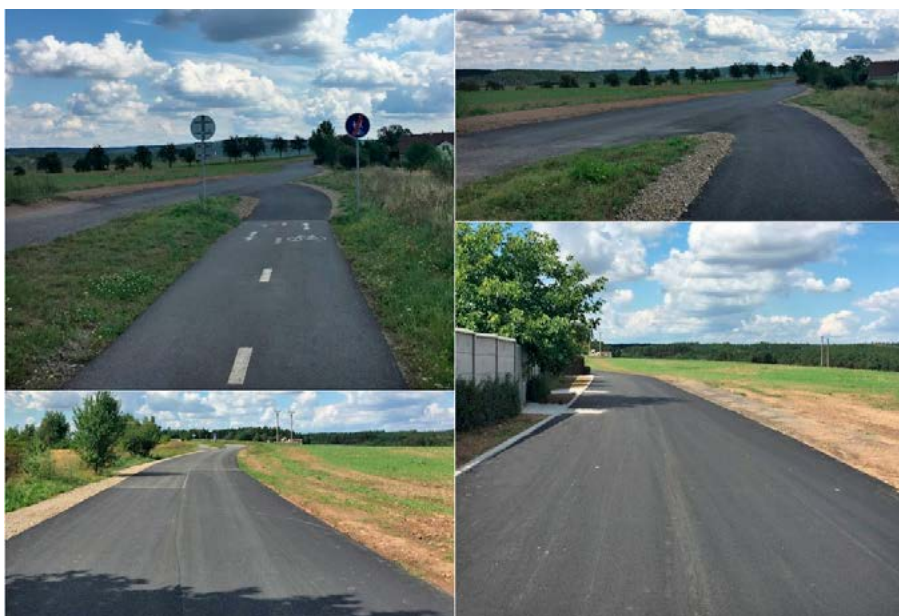
V uplynulých dnech byla ukončena rekonstrukce účelové komunikace ke kynologickému cvičišti.
