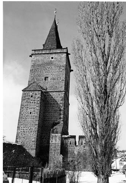
Pohled na Vysokou bránu od východu. Foto Hvězda, 2005
