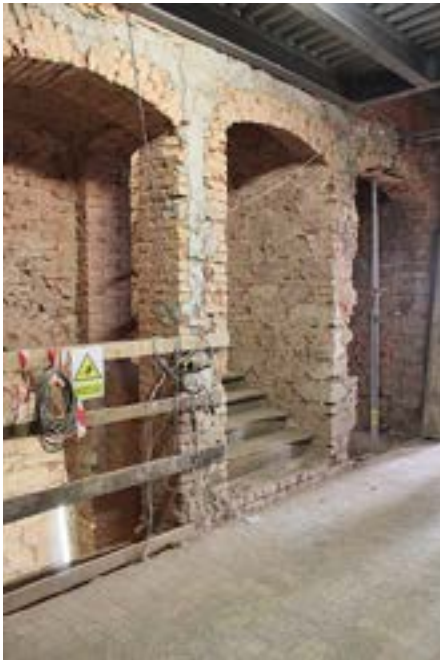
Centrální chodba při vstupu z průjezdu od náměstí, uprostřed schody vedoucí do klubovny
