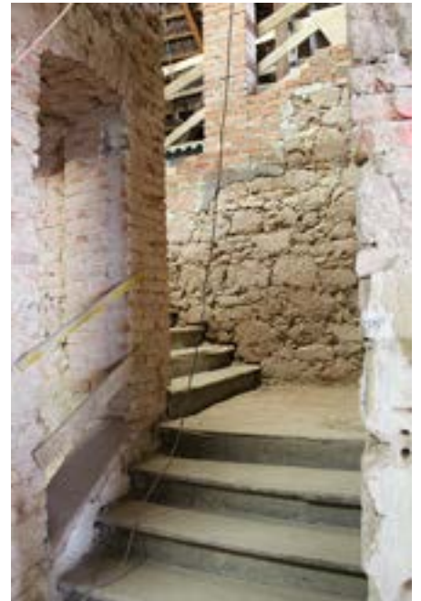
Schody, které vedou z centrální chodby do podkrovní klubovny
