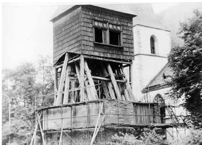
Oprava zvonice u kostela sv. Bartoloměje. Foto Hvězda, 2003
