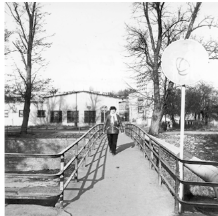
Lávka pro pěší přes Rakovnický potok u Sportovní ulice. Foto Hvězda, 1992
