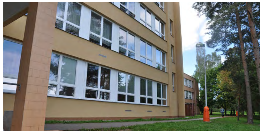
Rekonstrukci fasády pavilonu A 3. základní školy v Rakovníku zrealizovala společnost LAGUNA – Roman Topinka za cenu 861 004,68 Kč bez DPH.
