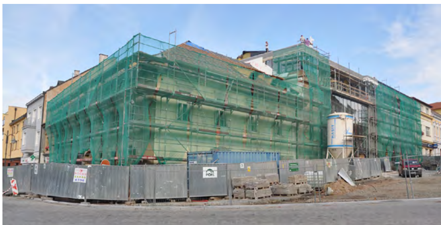
Práce na Víceúčelovém studijním a společenském centru finišují, nově byl stanoven termín pro dokončení na 15. 11. 2022. Následně budeme centrum vybavovat nábytkem.
