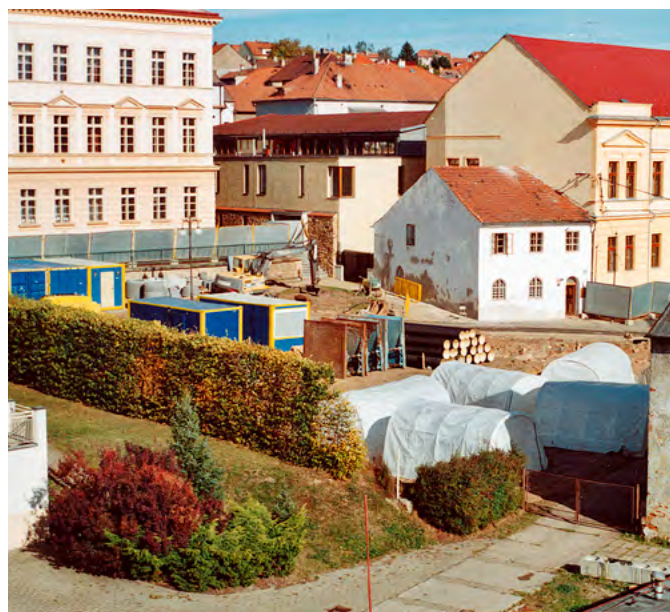
Prostor před 1. ZŠ před započatím výstavby školní jídelny. Foto Václav Hvězda, 2008
