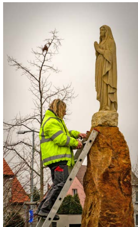
Úprava spáry mezi sochou a podstavcem
