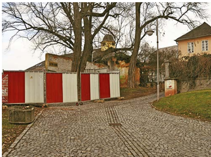
Dvě etapy rekonstrukce areálu Letního kina v Rakovníku, spočívající v obnově hlediště a pódia, již byly realizovány. V letech před tím bylo investováno do technologické části letního kina (nový digitální projektor) a opravy WC. Nyní je na řadě realizace úpravy vstupu a prostranství před letním kinem, čímž bude celková obnova areálu letního kina završena.
