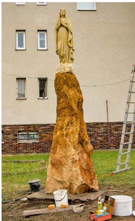
Socha v průběhu osazování
