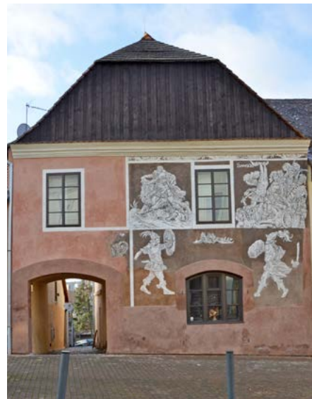
Celkový pohled na opravené průčelí.
