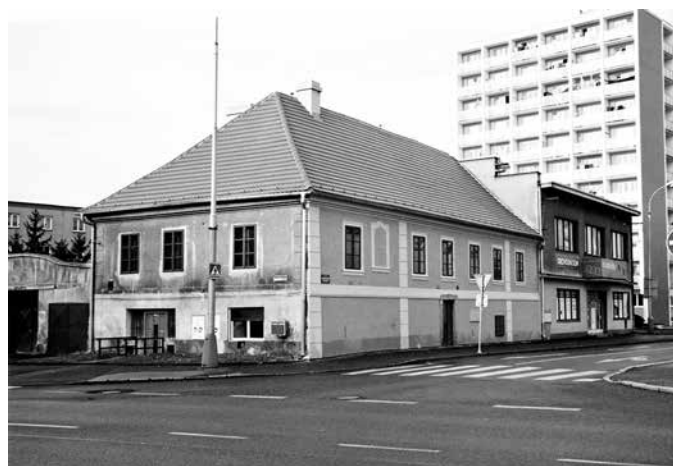
Ulice Dukelských hrdinů. Budovy Domu osvěty. Foto Hvězda, 2010
