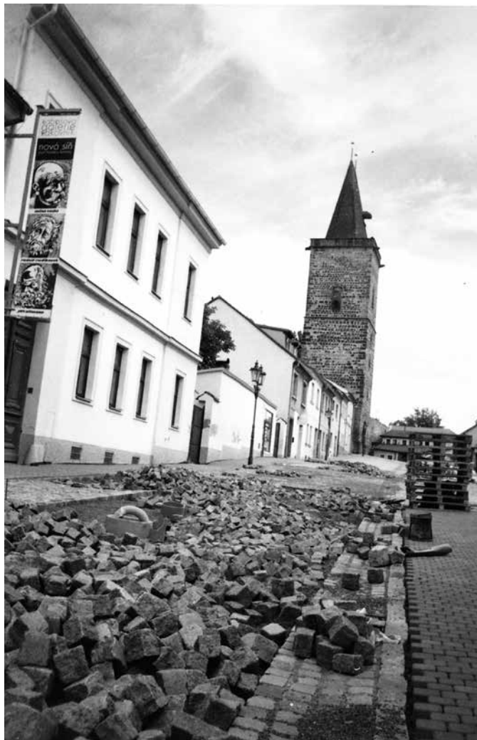
Vsoká ulice při opravě dláždění. Foto Štýbrová, 2010–2011
