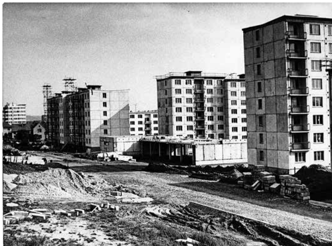
Výstavba pod starou nemocnicí – ul. Pod Nemocnicí. Foto neznámý autor, 1976
