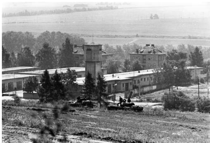
Srpen 68. Pohled na kasárna od severu. Foto Hvězda, 1968
