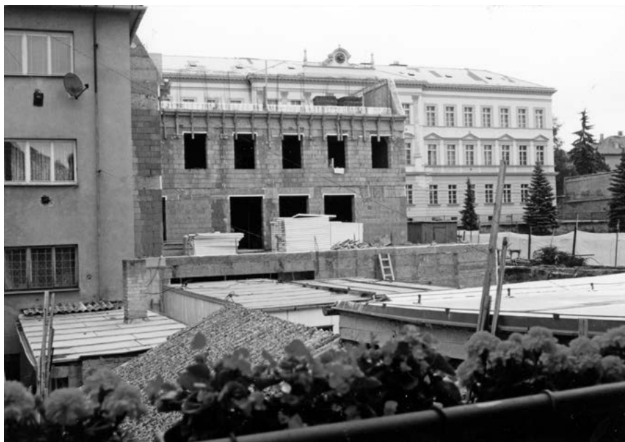
Výstavba finančního úřadu v Martinovského ulici. Foto Hvězda, 1996
