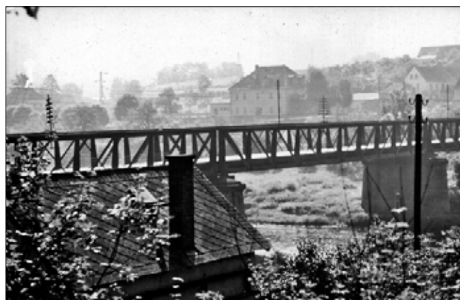
Starý silniční most v Rostokách u Křivoklátu. Foto Hvězda (1963)
