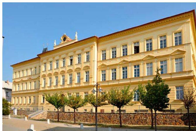
Oprava fasády a výměna střešní krytiny 1. ZŠ Rakovník byla začátkem září dokončena.
