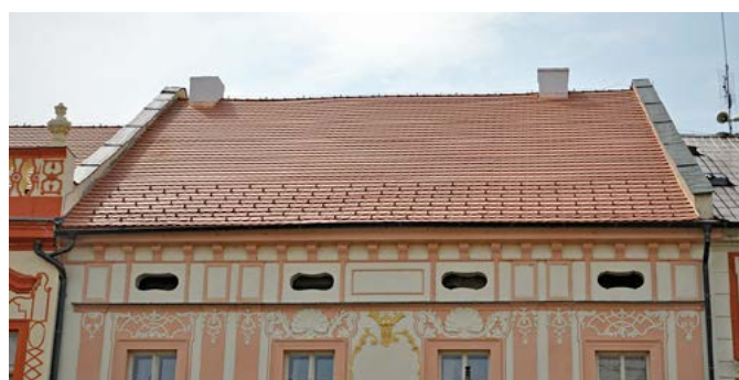
Na další budově radnice proběhla výměna střešní krytiny. Cena výměny byla 1 278 362 Kč bez DPH, z toho 463 000 Kč bylo pokryto z dotace.
