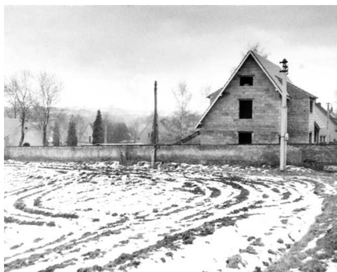
Výstavba u Židovského hřbitova. Foto Hvězda, 70. léta
