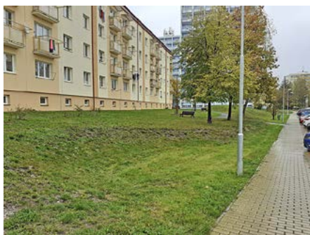
Okolní zpevněné i nezpevněné plochy jsou spádovány do průlehu v zeleni, ve kterých se shromáždí voda při přívalem deštích. Postupně se voda odpaří nebo vsákne.
