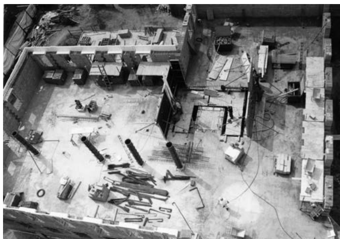
Výstavba finančního úřadu v Masné ulici. Foto Hvězda, 90. léta
