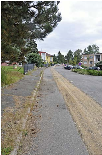
Město pokračuje v rekonstrukci ulic na Vinohradech – kompletní rekonstrukce povrchů, opravy inženýrských sítí a rekonstrukce veřejného osvětlení právě probíhá v ulici Pod Václavem a Křikavova.
