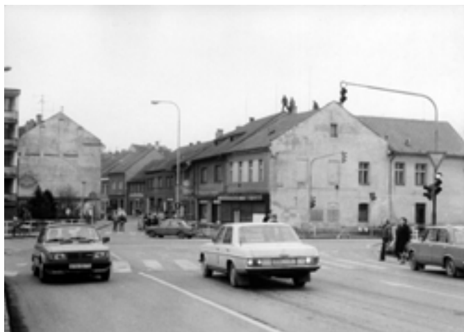
Křižovatka "Na Váze" před demolicí budovy cukrárny. Foto Hvězda (1986)
