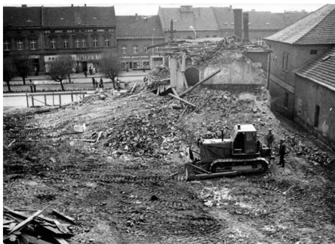
Bourání Masárekovic domu na Husově náměstí před výstavbou hotelu. Foto Hvězda, 1977
