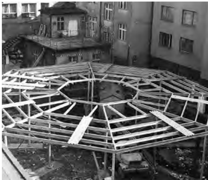
Výstavba haly nové spořitelny v Masné ulici. Foto V. Hvězda 1993
