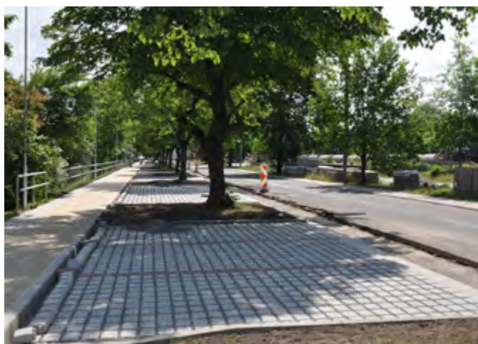
Výstavba parkoviště u nádraží se blíží ke konci
