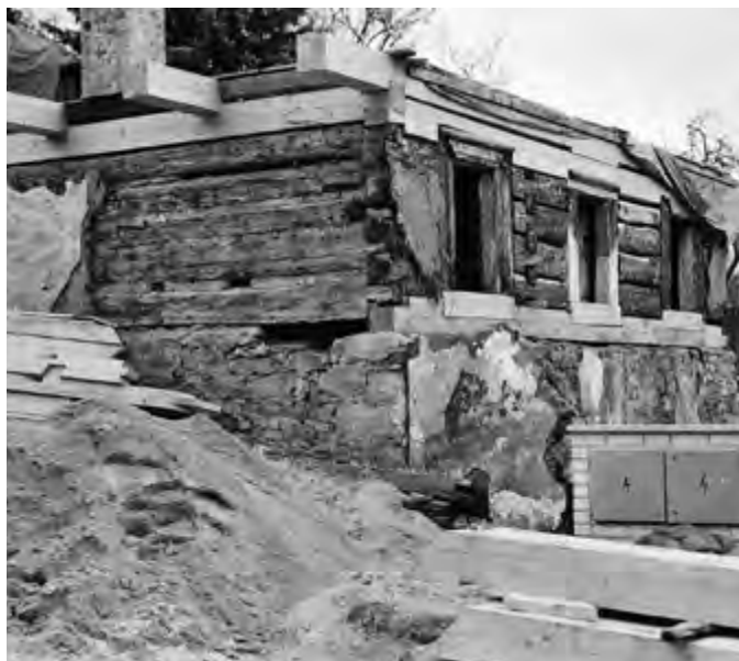
1. Copak se to v Rakovníku opravovalo? Foto V. Hvězda, 2011
