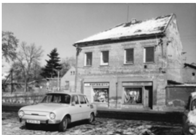
Obytný dům na nároží ulic Pražská a Smetanova (pod Hrádkem). Foto Hvězda (1985)
