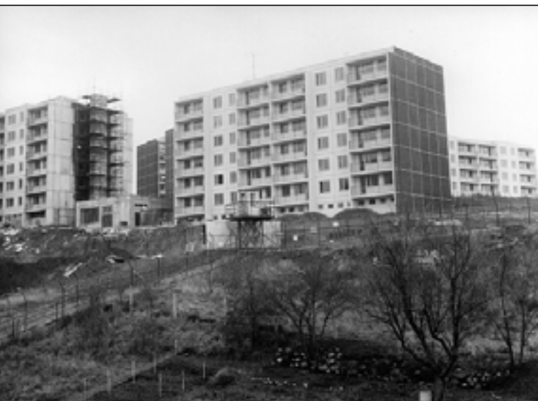
Výstavba sídliště Bendovka s věžeňským plotem a strážní věží (špačkárna). Foto Hvězda. (1988)
